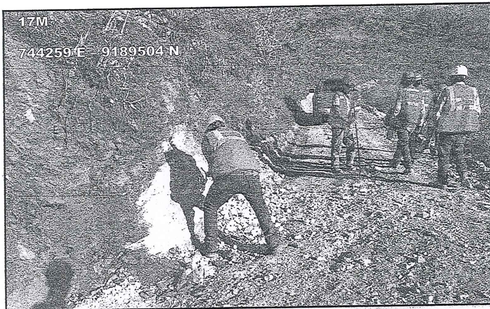
FOTO N° 13: Perfilado de taludes en puntos críticos.
