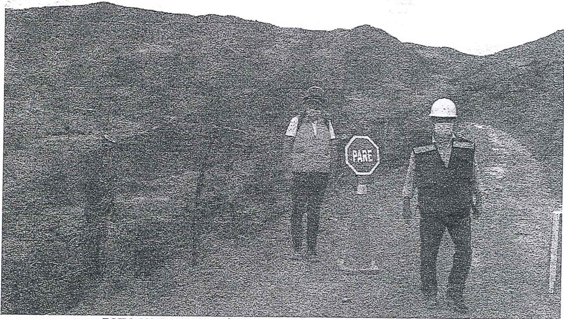
FOTO N° 5: Verificación del Perfilado de Superficie de Rodadura
