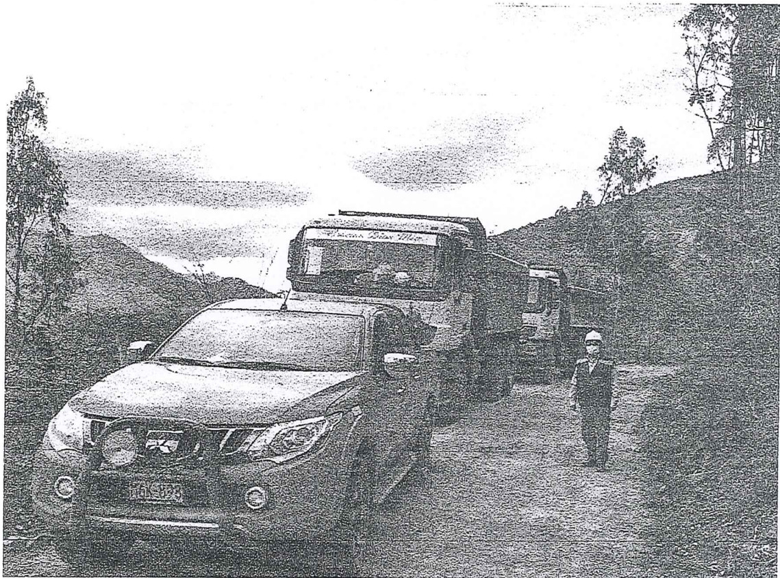
FOTO N° 2: Movilización de Equipos y Maquinaria
