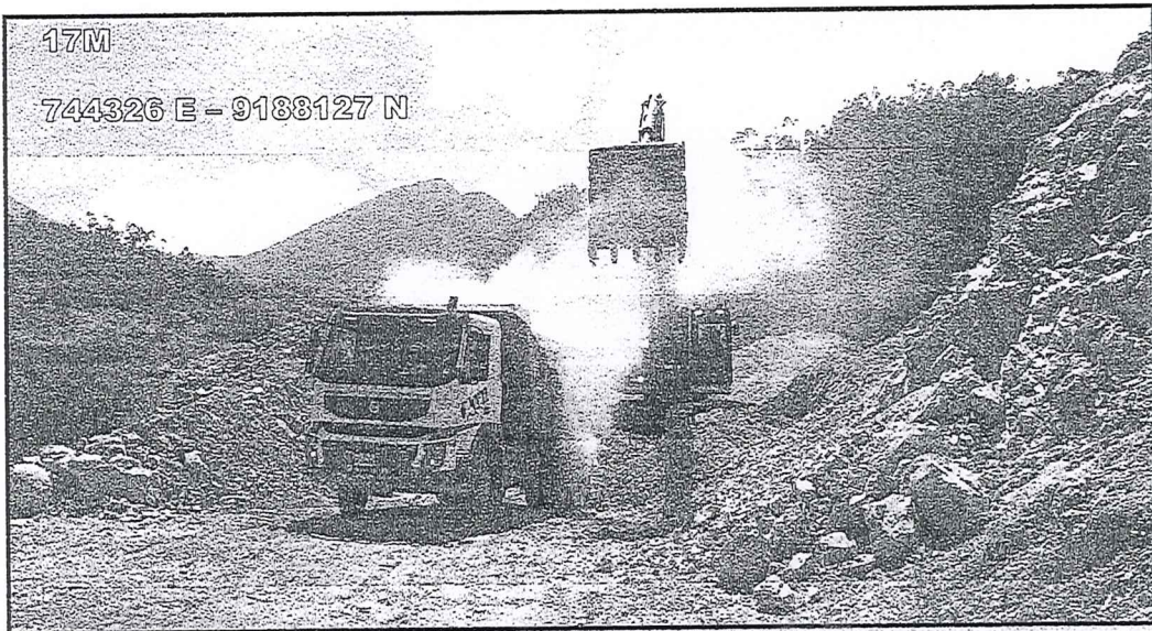
FOTO N° 10: Carguío de material granular al tramo.
