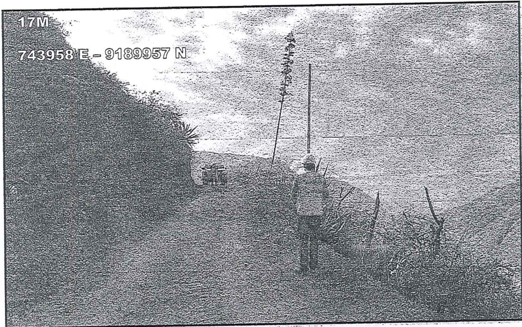
FOTO N° 05: Trabajo de trazo y replanteo de topografía.
