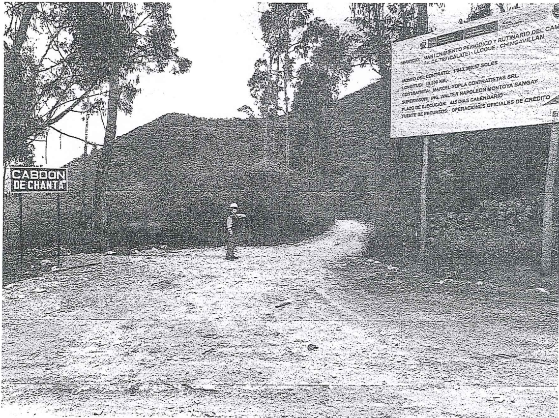
FOTO N° 1: Verificación de Colocación de Cartel Informativo de Servicio
